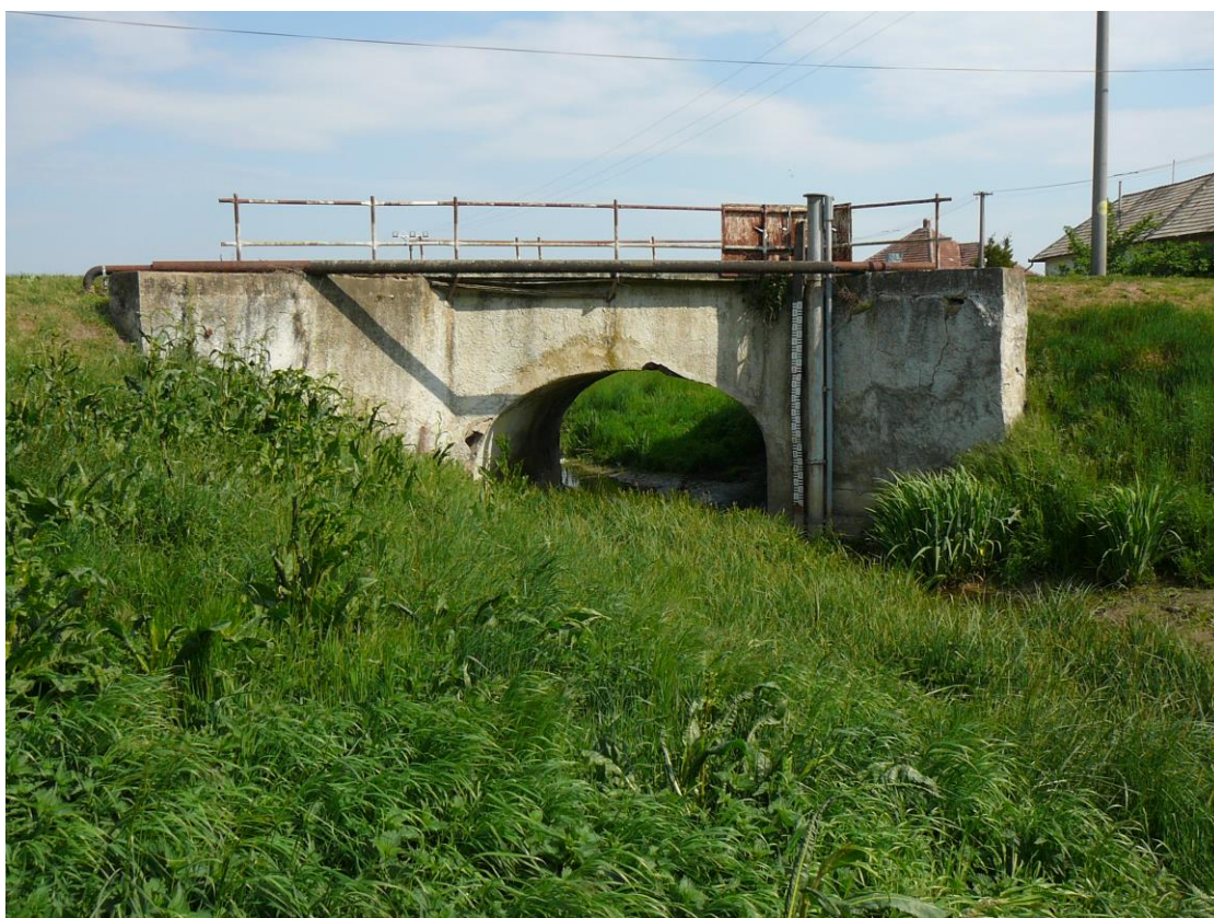
4. Pohľad na výtokovú stranu mosta
