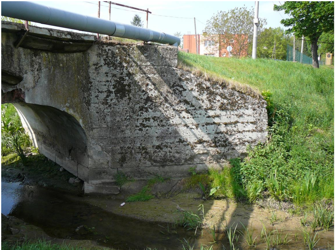
7. Pohľad na pravé šikmé krídlo – vtoková časť
