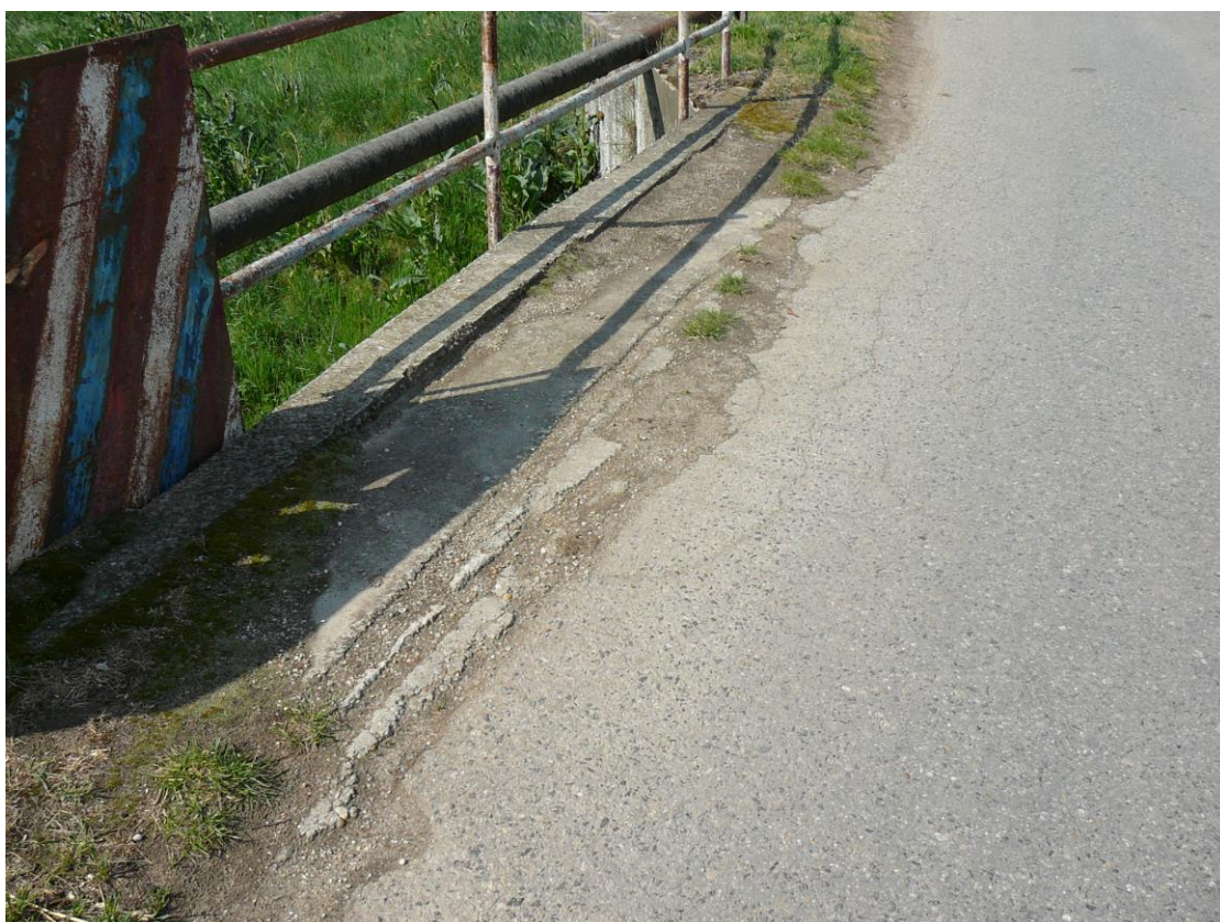
14. Pohľad na rímsu a vozovku – výtoková strana
