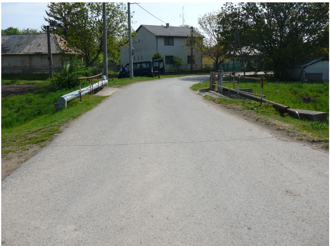
2. Pohľad na mostný objekt – zo smeru Château Rúbaň
