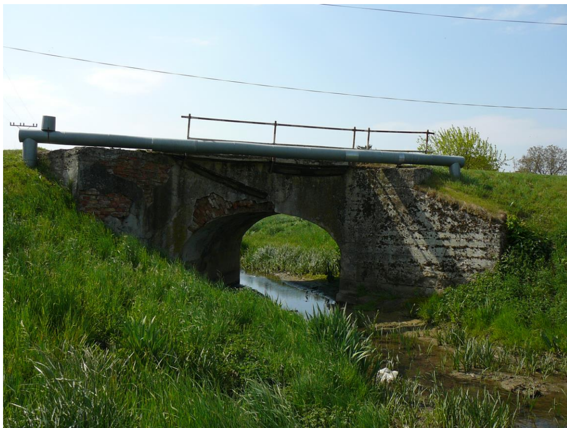
3. Pohľad na vtokovú stranu mosta
