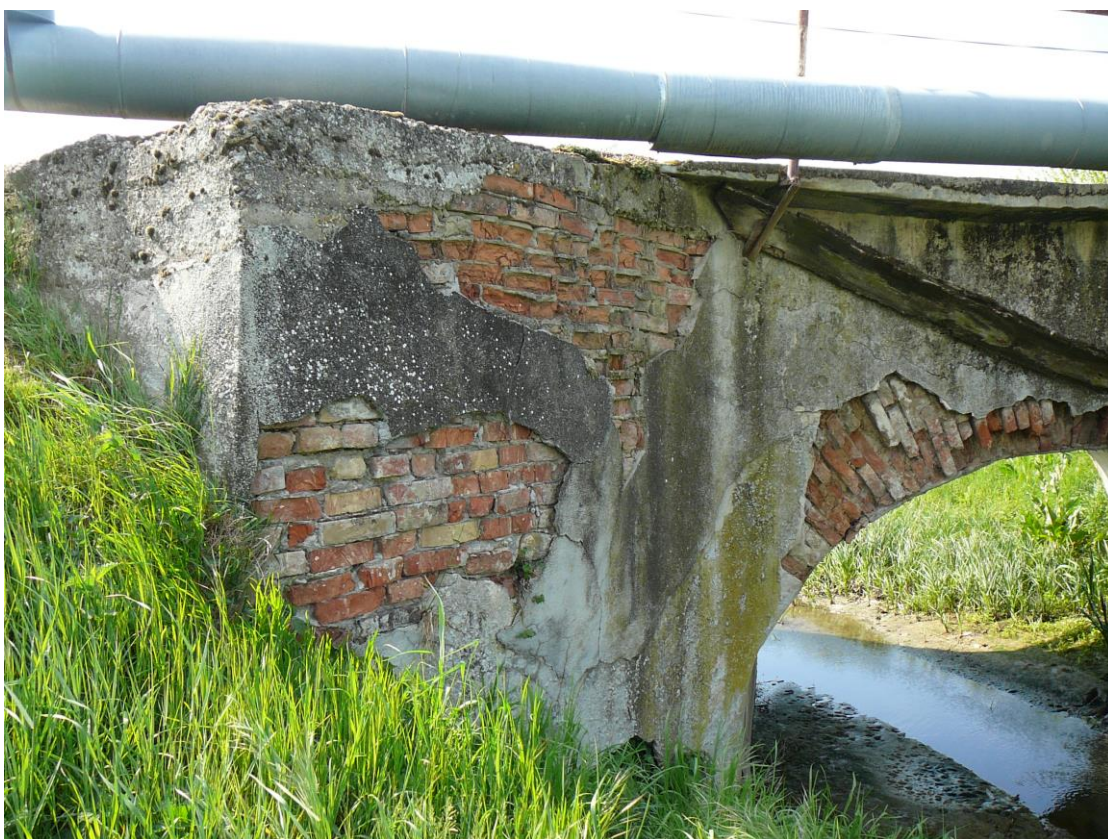
6. Pohľad na ľavé šikmé krídlo – vtoková časť
