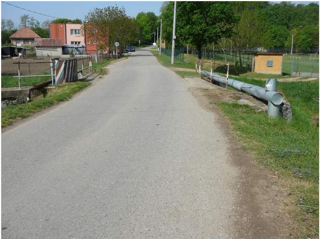
1. Pohľad na mostný objekt – zo centrum obce Rúbaň
